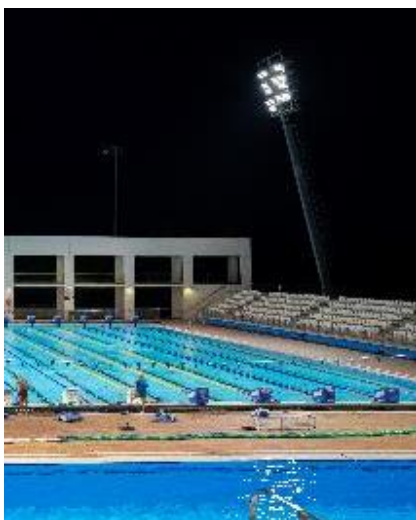
Iluminación de piscina al aire libre
