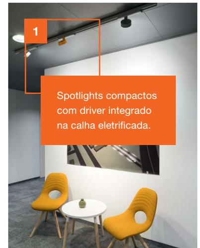
Spotlights compactos com driver integrado na calha eletrificada.
